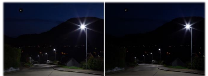
Das Beleuchtungskonzept zeigt wie Straßen bei weniger Lichtemissionen gleichmäßiger ausgeleuchtet werden können (Bild rechts). (Ingenieurbüro G. Volz GmbH & Co. KG)
