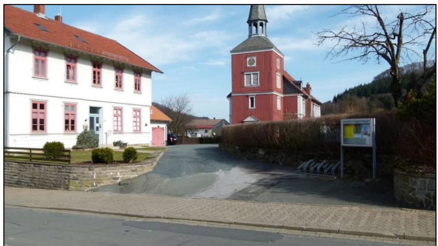
Istzustand: Der Eingangsbereich zur St. Thomas Kirche und zum Gemeindehaus ist durch seinen Split Belag nicht barrierefrei zu erreichen.
